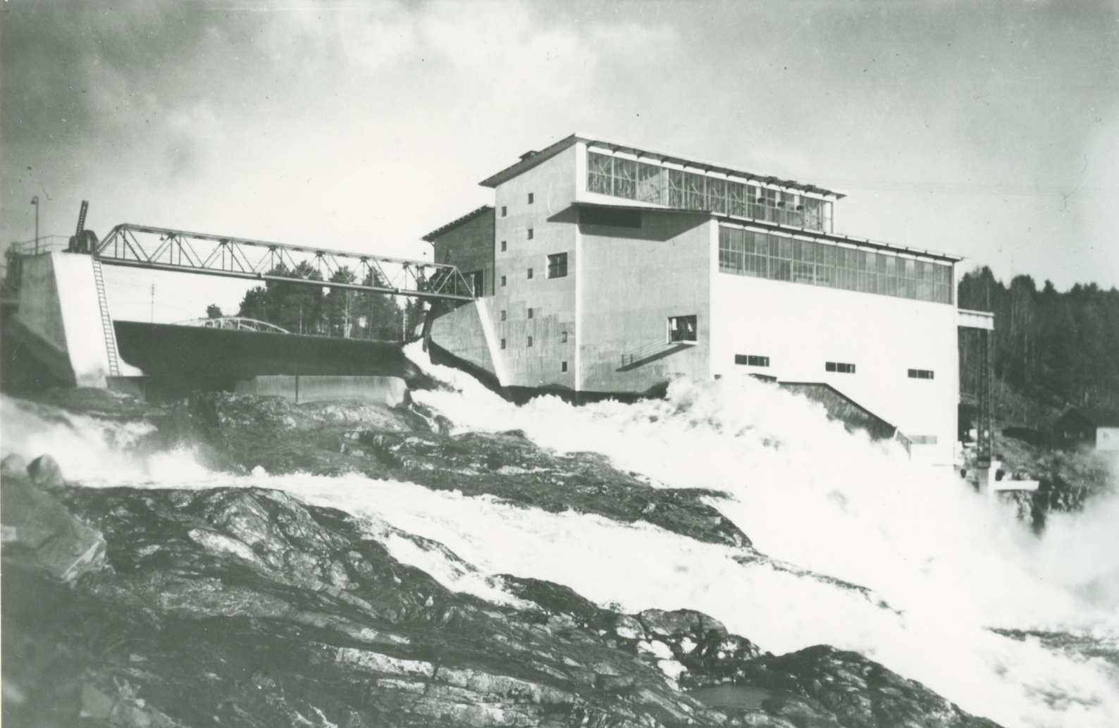
Kraftverksbyggnad i Hammarforsen, Oswald Almqvist © Arkdes, public domain
